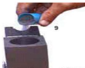
9. Despeje o conteúdo do cartucho no molde. No fundo do cartucho há material mais fino, importante para o início da ignição. Verifique se não restou material grudado no fundo do cartucho.
